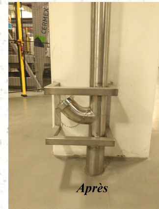
Modification écoulement PVC, par tuyauterie inox
