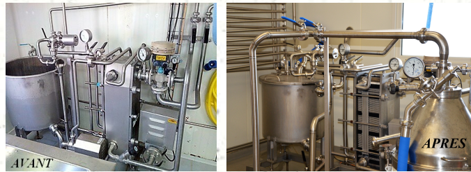
Déplacement et modification de pasteurisateur
