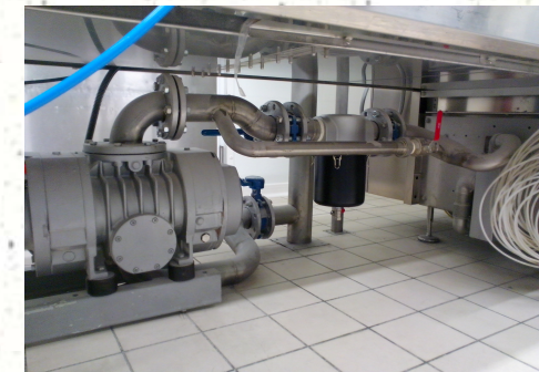
Installation pompe à vide
