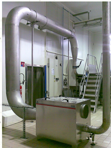
Fabrication d'une tuyauterie de soufflage
