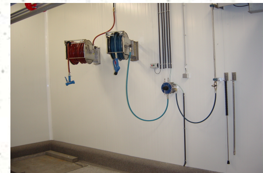
Conception tuyauterie HP pour station de lavage
